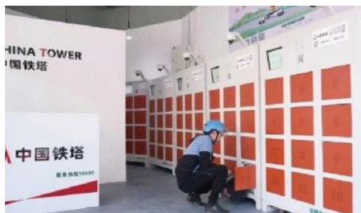
铁塔换电项目
